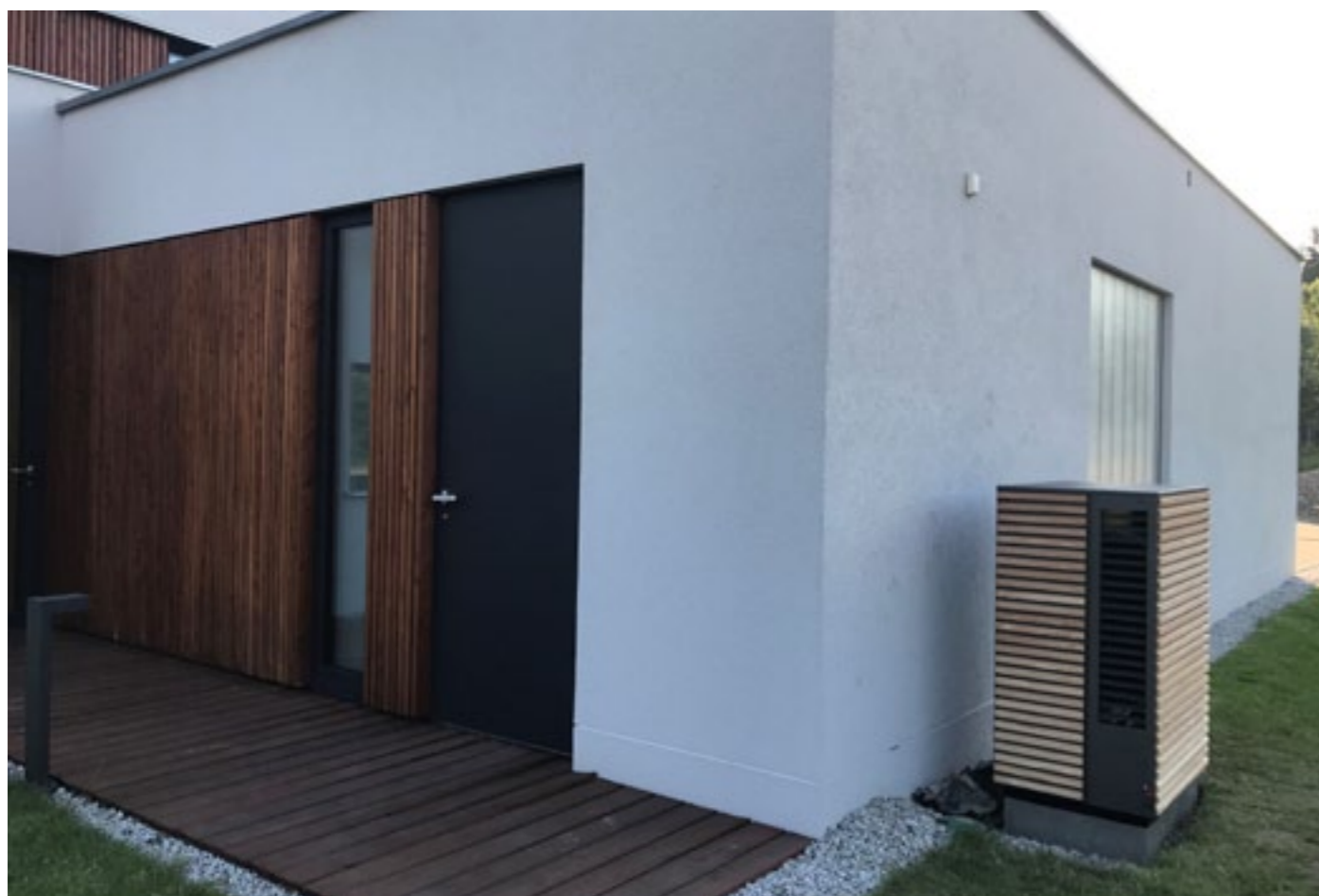
Jednostka zewnętrzna SYSTEMU M zlokalizowana na zewnątrz budynku
