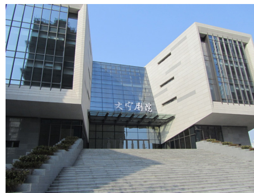
Außenansicht New Opera Treppenaufgang
